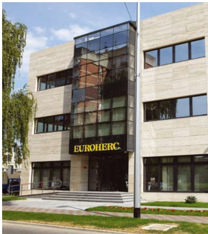
Nova poslovna zgrada u Velikoj Gorici iduće će godine postati podružnica
